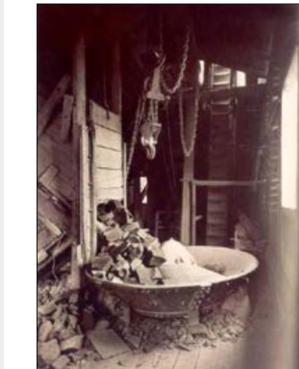
*Kreisläufer, Aufnahme von 1920. Das Material kam über eine Schütte von links oben gerastet. Die Menge wurde durch den Schieber geregelt. Im Brecherhaus miserte eine vertikale Escalatorwelle, die durch die Veränderung des Ringgutes das Gestein einwärts löste und brach.*
